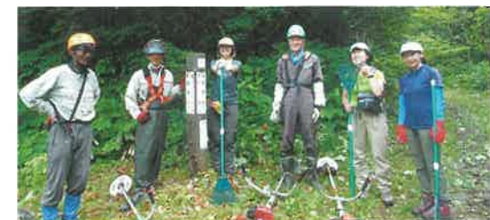
自然歩道の点検・整備作業
